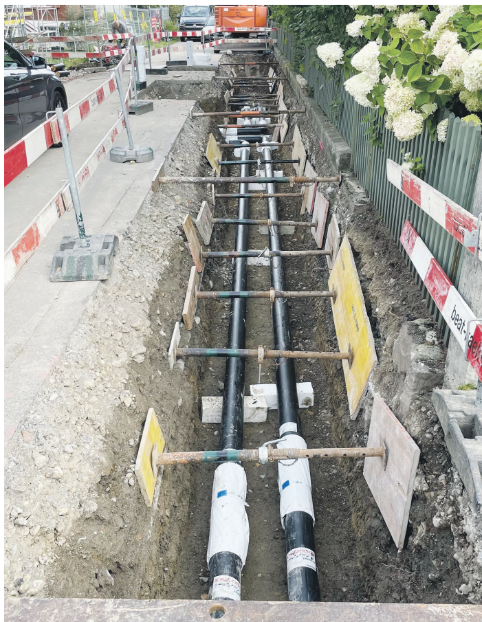
Das Fernwärmenetz der Energie Einsiedeln AG wächst.
