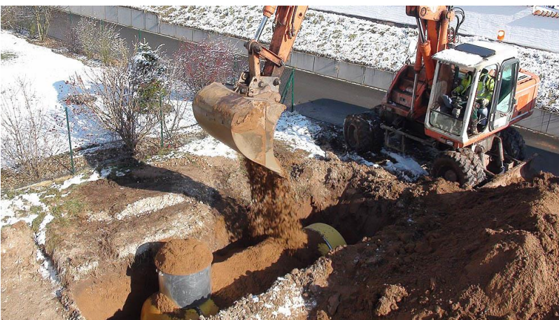
Gastank wird mit Sand überdeckt
