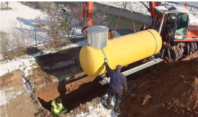
Gastank wird in Grube gesetzt
